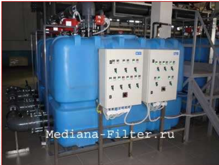
Установка хлорирования
